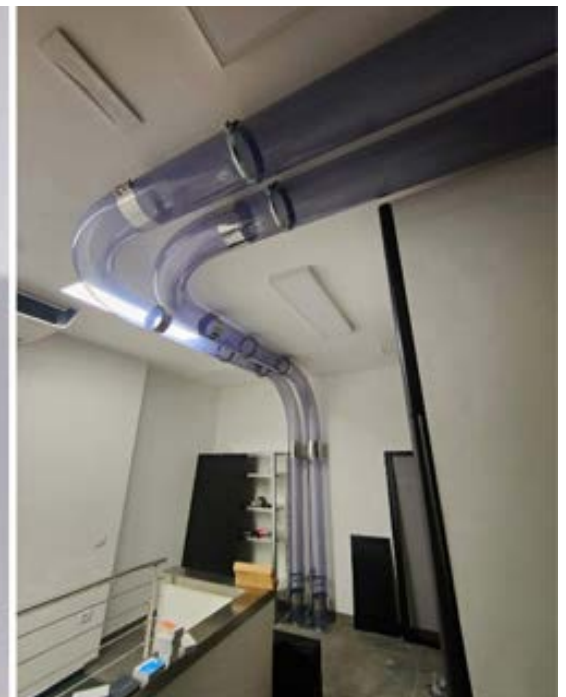
Figura 7. Linea di tubi pneumatici per recapito di posta pneumatica attraverso ambienti complessi (a); manicotto antincendio per tubi di posta pneumatica (b) (Aerocom)
