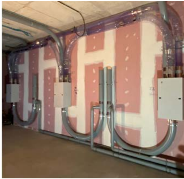
Figura 6. Sistema deviatore di linee singole di interscambio controllato elettronicamente (a); insieme di deviatori di interconnessione di diverse linee (b) (Aerocom)
