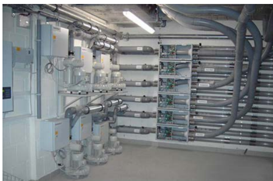
Figura 4. Sala di generazione di potenza pneumatica (a) e di distribuzione dei flussi di trasporto di posta pneumatica (b) (Aerocom).
